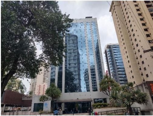
Fachada do empreendimento – Rua Vilela
