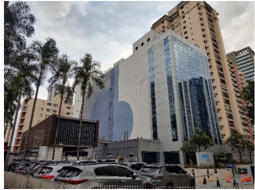
Fachada do empreendimento – Rua Vilela x Rua Padre Estevão Pernet
