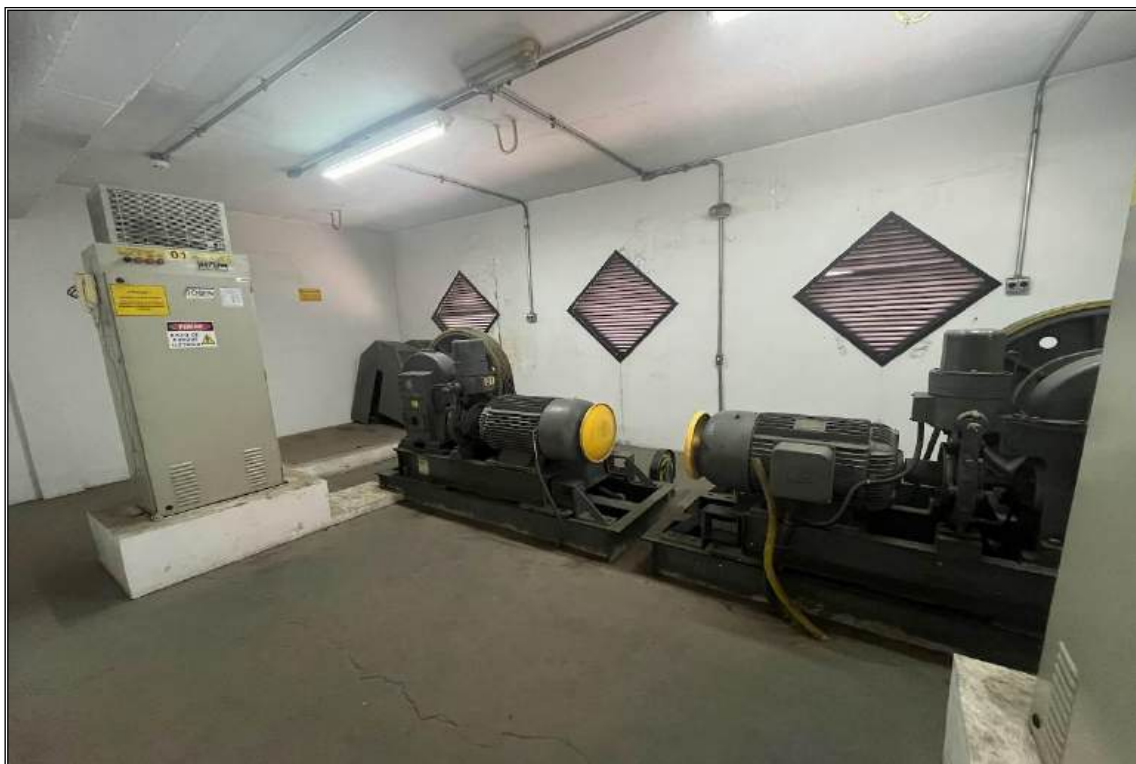
COBERTURA – CASA DE MÁQUINAS
