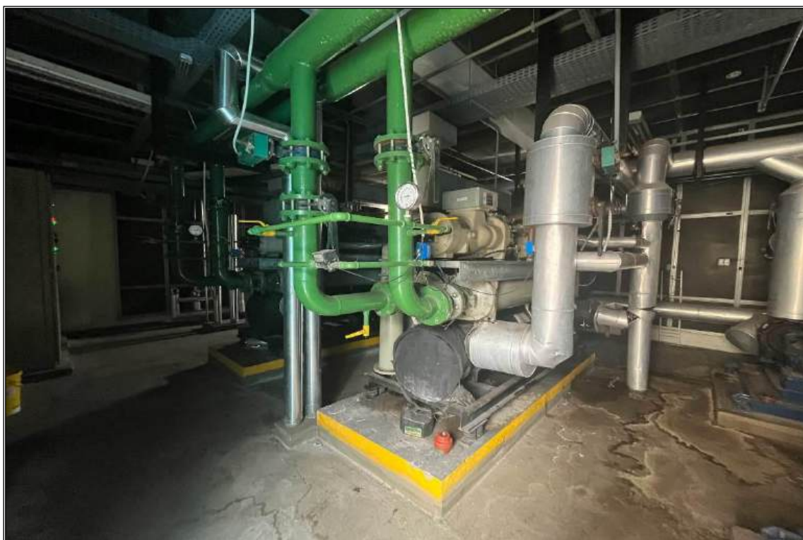
COBERTURA – CASA DE MÁQUINAS
