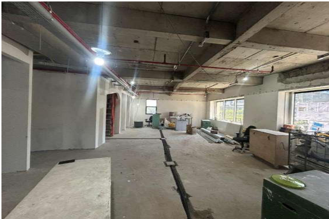
Conjunto 41B – Em Obras
