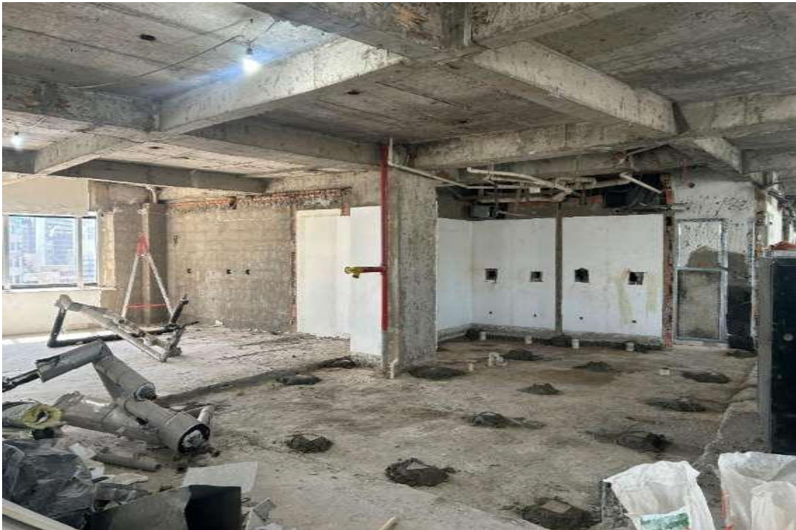
12º Andar – Em Obras
