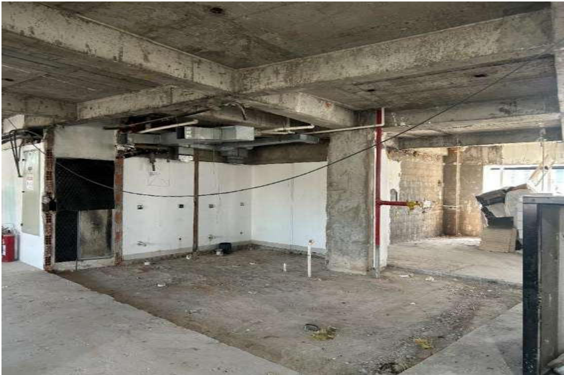
12º Andar – Em Obras
