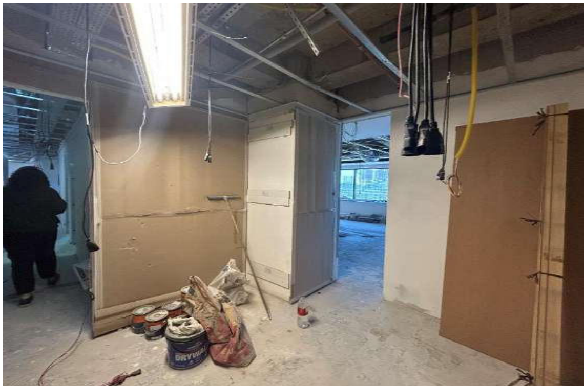
Conjunto 62 – Em Obras
