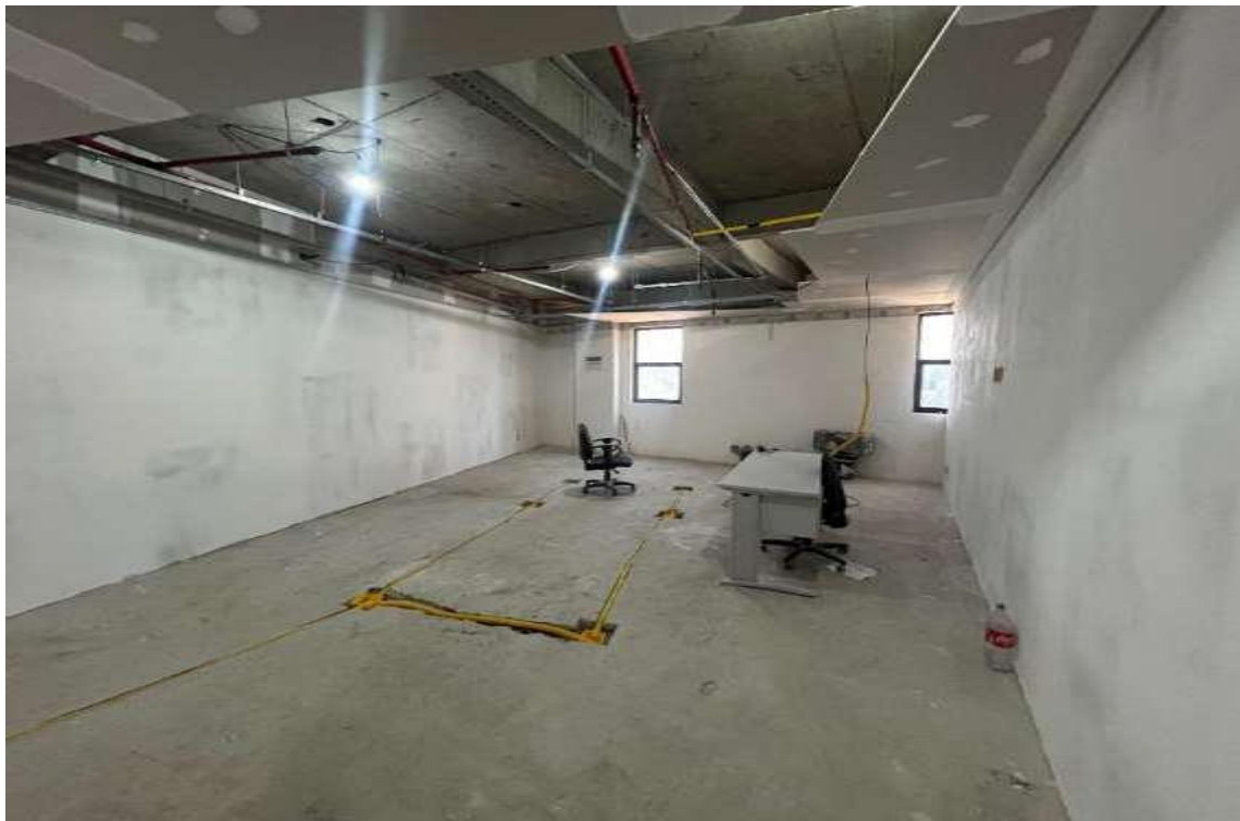
Conjunto 41B – Em Obras
