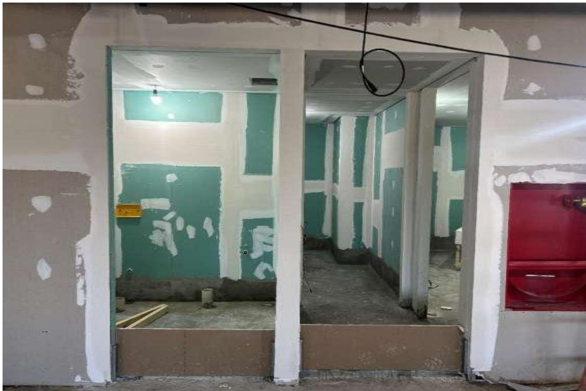
Conjunto 92 – Em Obras
