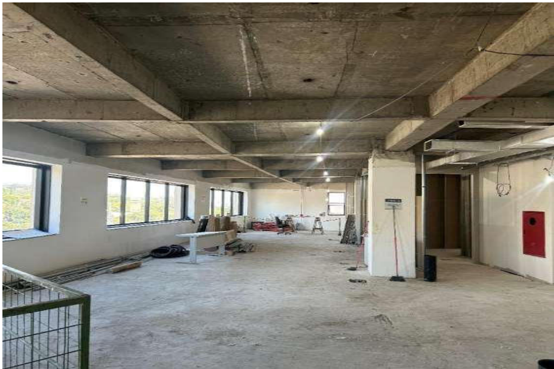
Conjunto 81 – Em Obras
