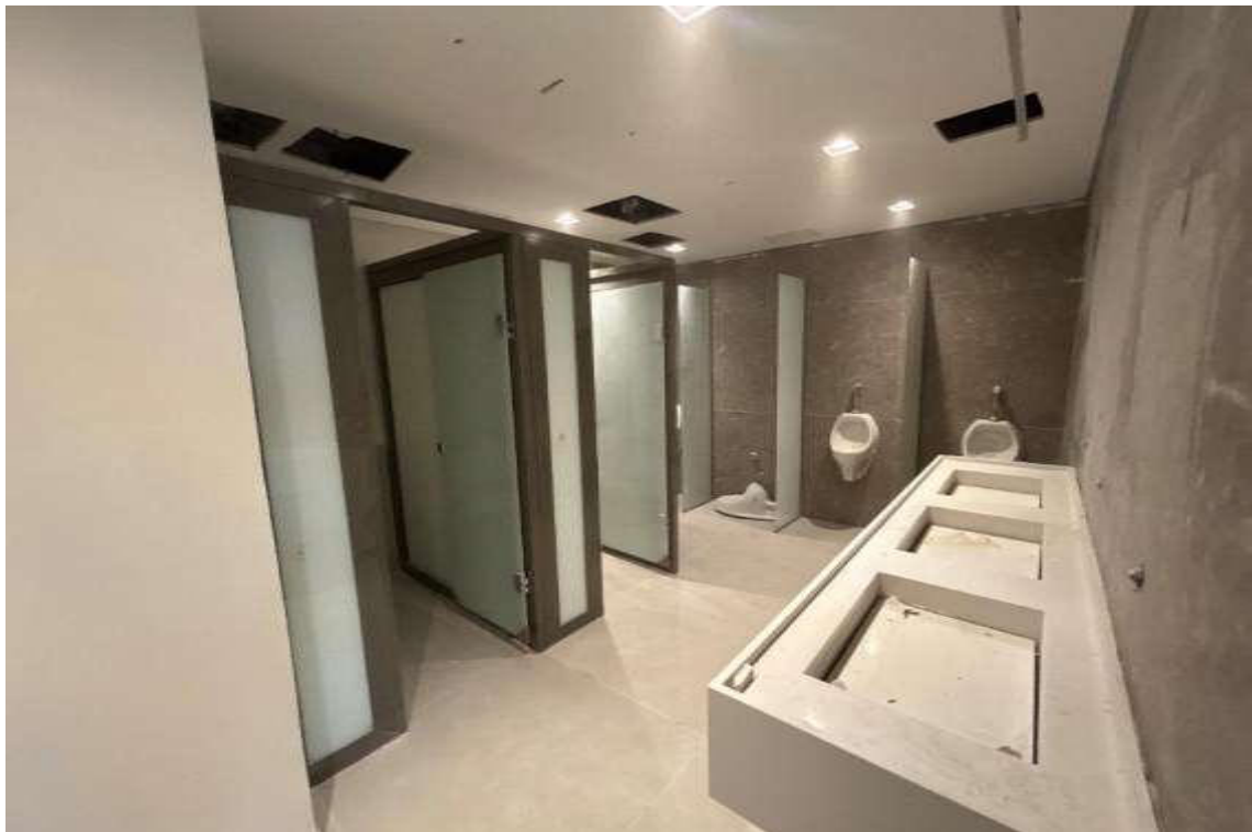
Conjunto 62 – Sanitário Em Obras
