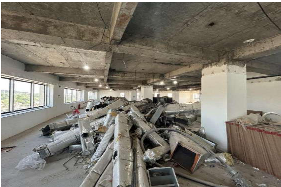
12º Andar – Em Obras
