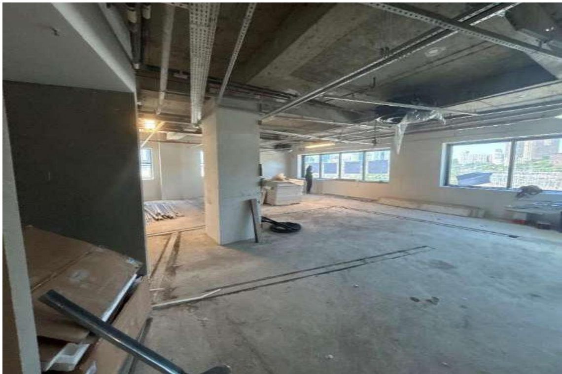
Conjunto 62 – Em Obras
