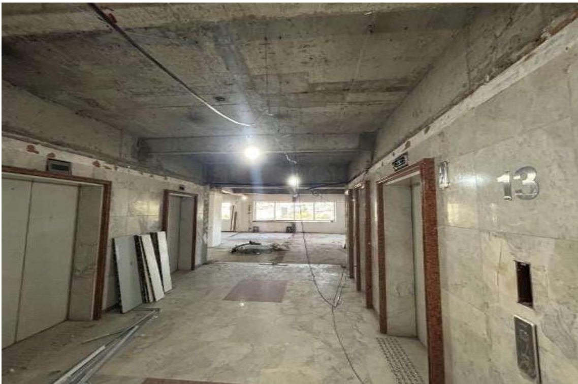
13º Andar – Hall Elevadores Em Obras
