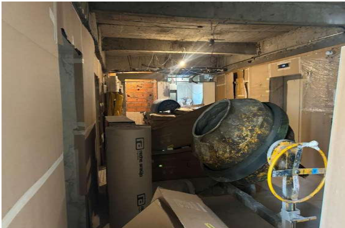
15º Andar – Hall Elevadores Em Obra
