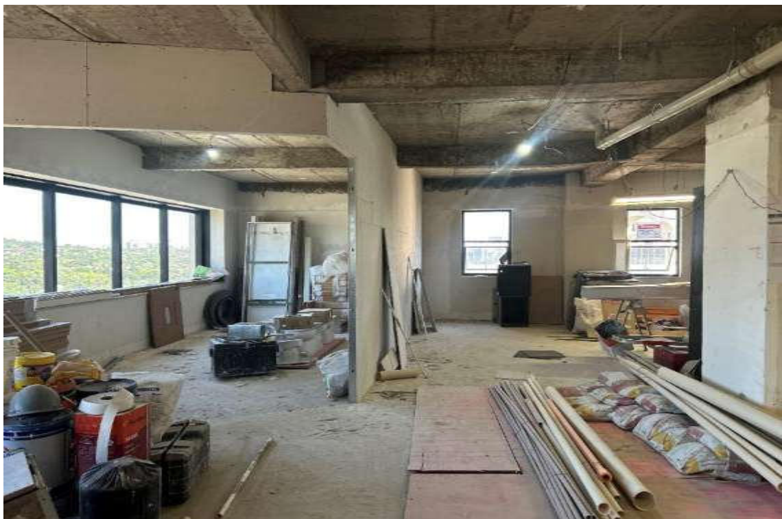
Conjunto 152 – Em Obra
