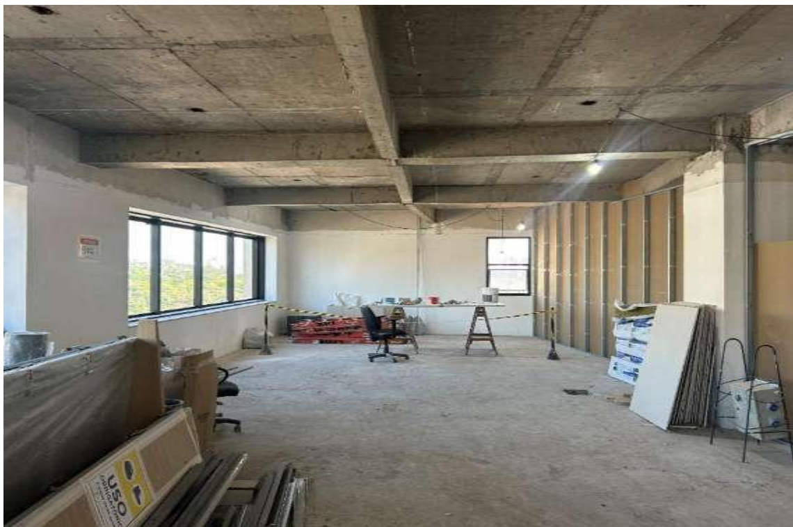
Conjunto 81 – Em Obras
