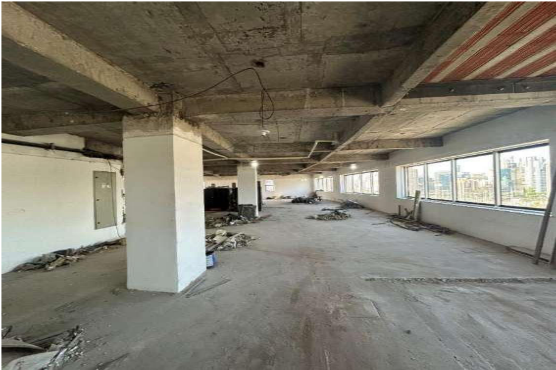
13º Andar – Em Obras
