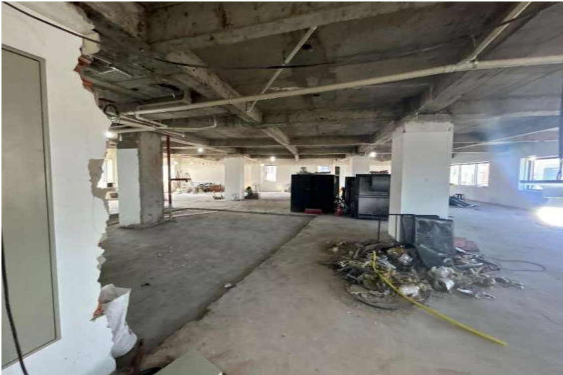
13º Andar – Em Obras
