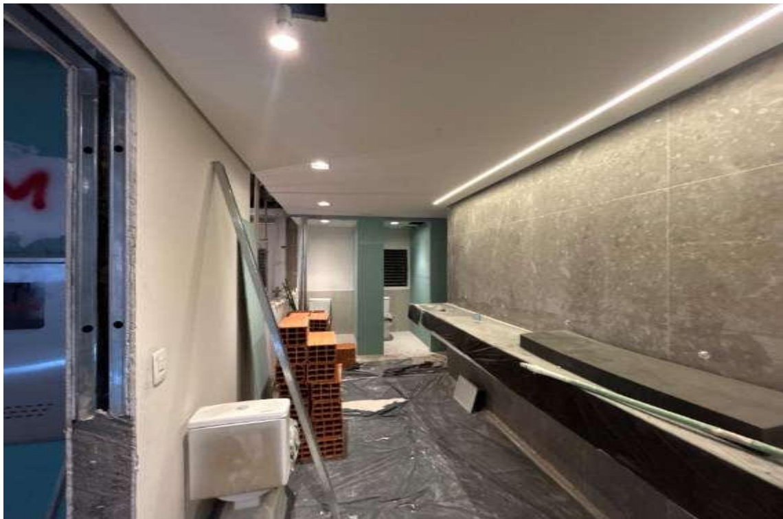
Conjunto 151 – Em Obra
