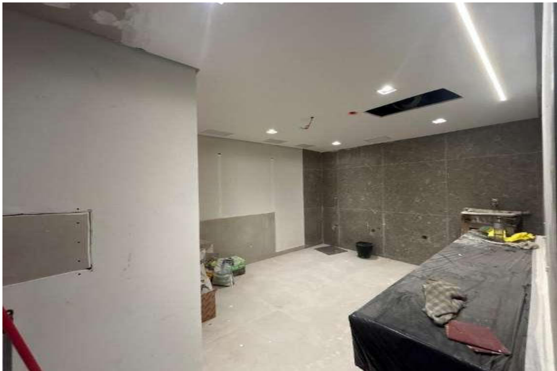
Conjunto 151 – Em Obra
