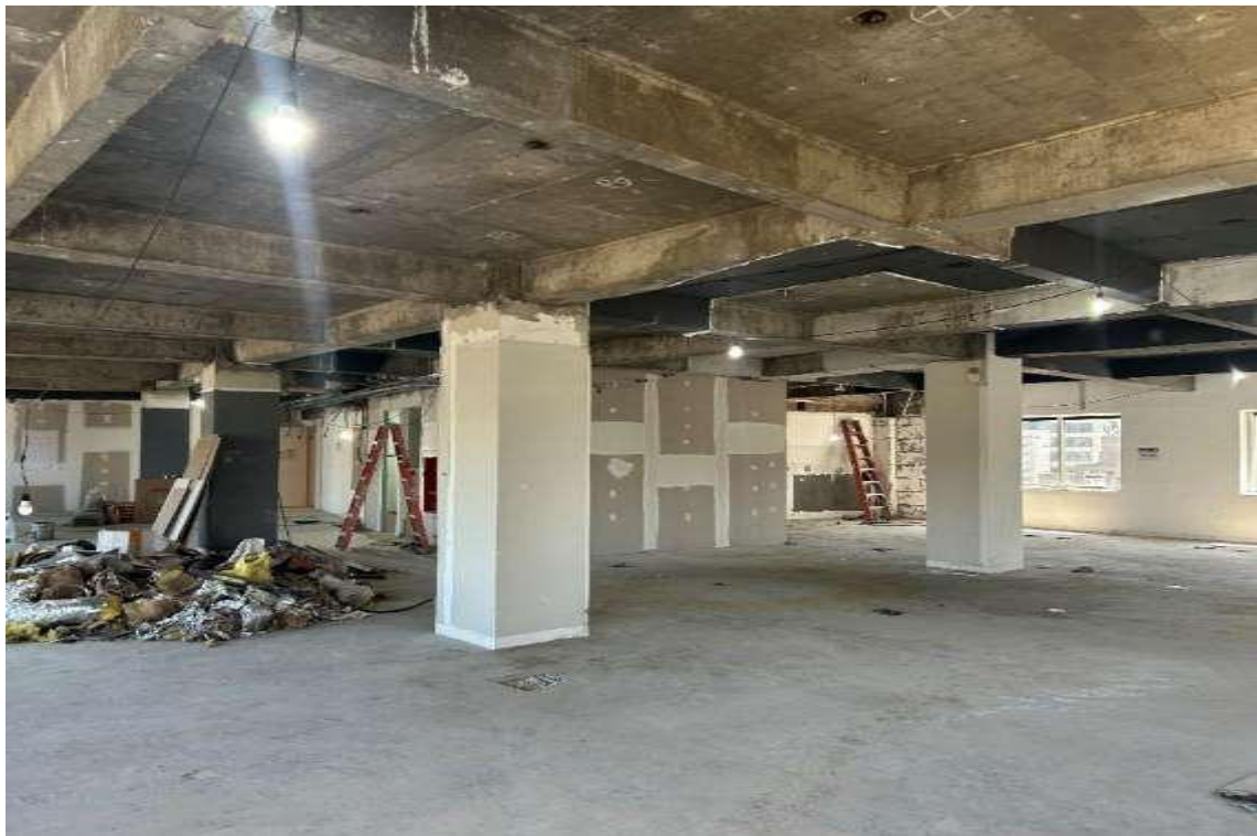
Conjunto 92 – Em Obras
