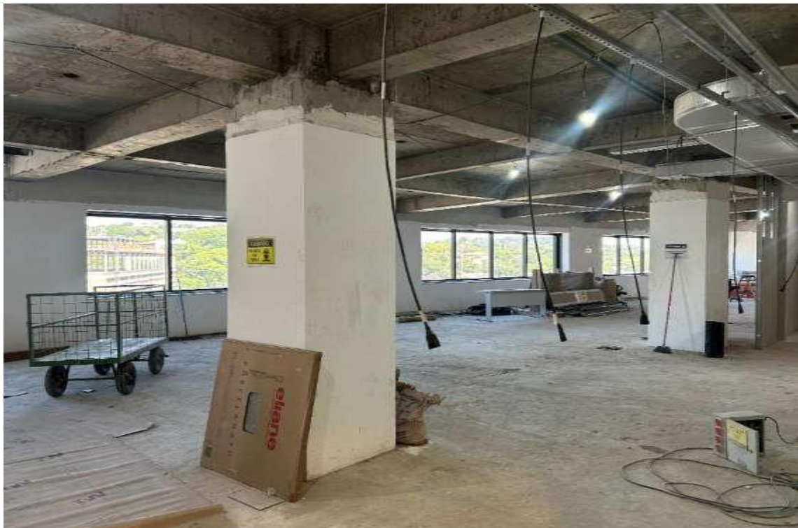
Conjunto 81 – Em Obras
