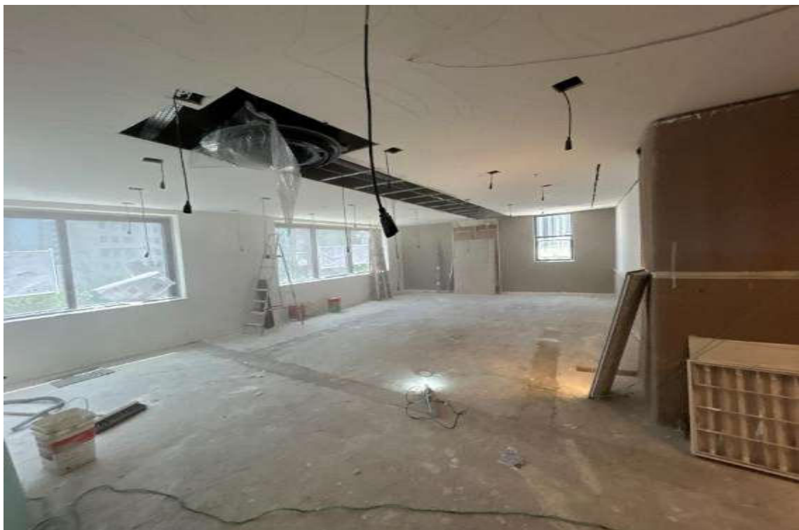
Conjunto 62 – Em Obras
