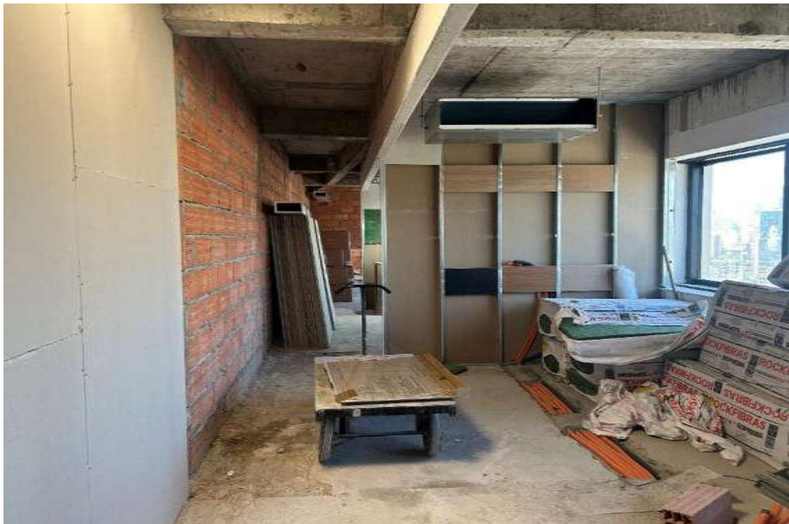
Conjunto 151 – Em Obra
