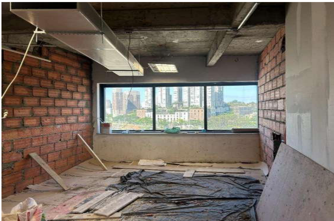
Conjunto 151 – Em Obra
