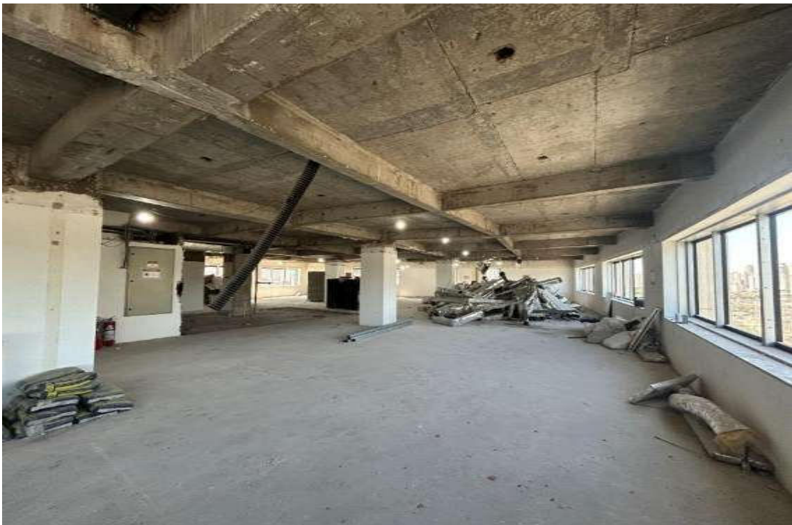
12º Andar – Em Obras
