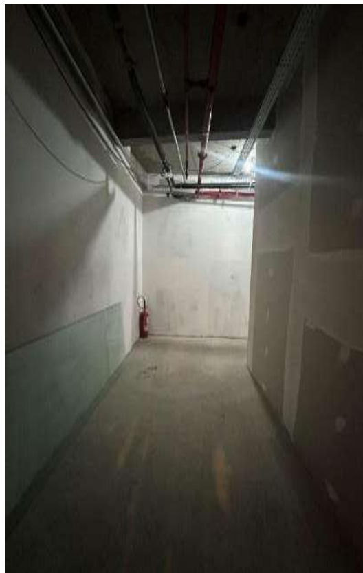
Conjunto 41B – Em Obras
