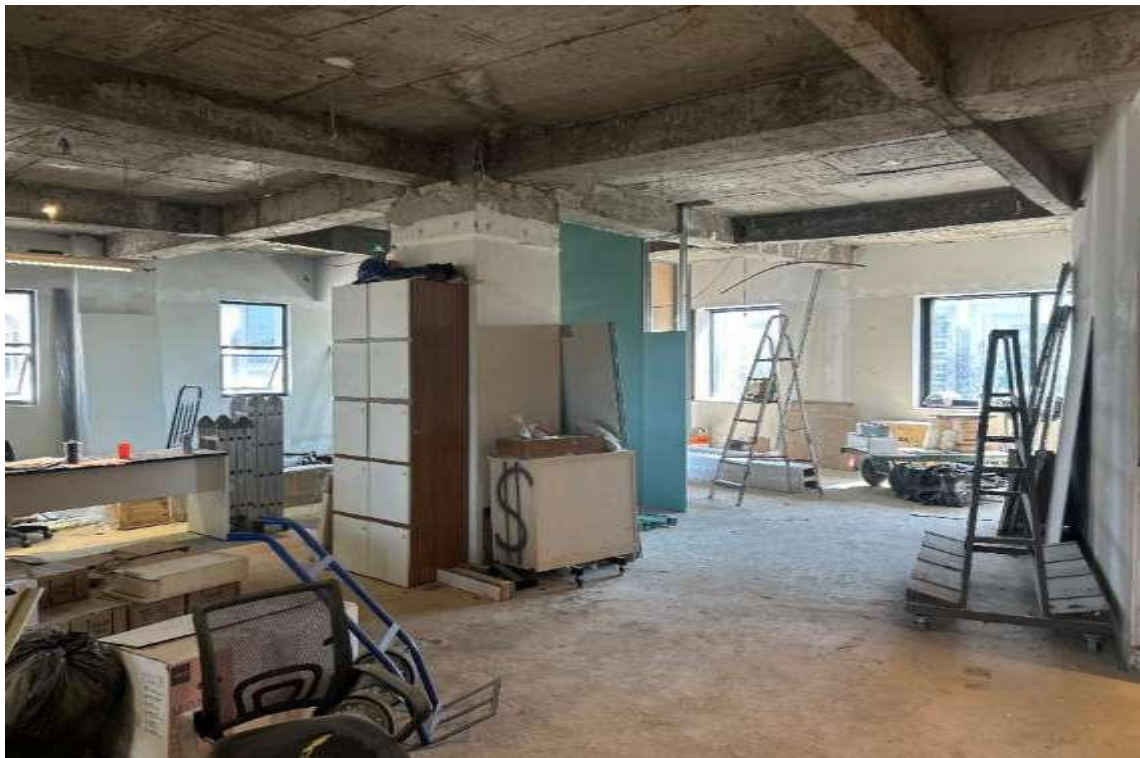
Conjunto 152 – Em Obra
