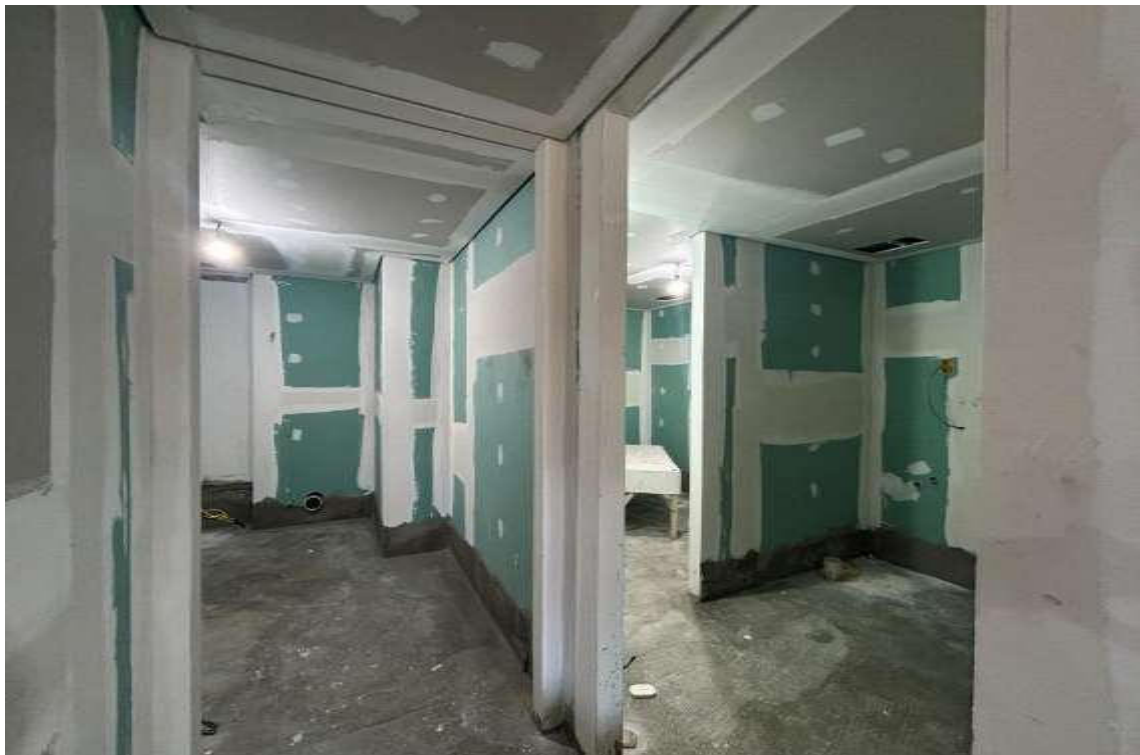
Conjunto 92 – Em Obras
