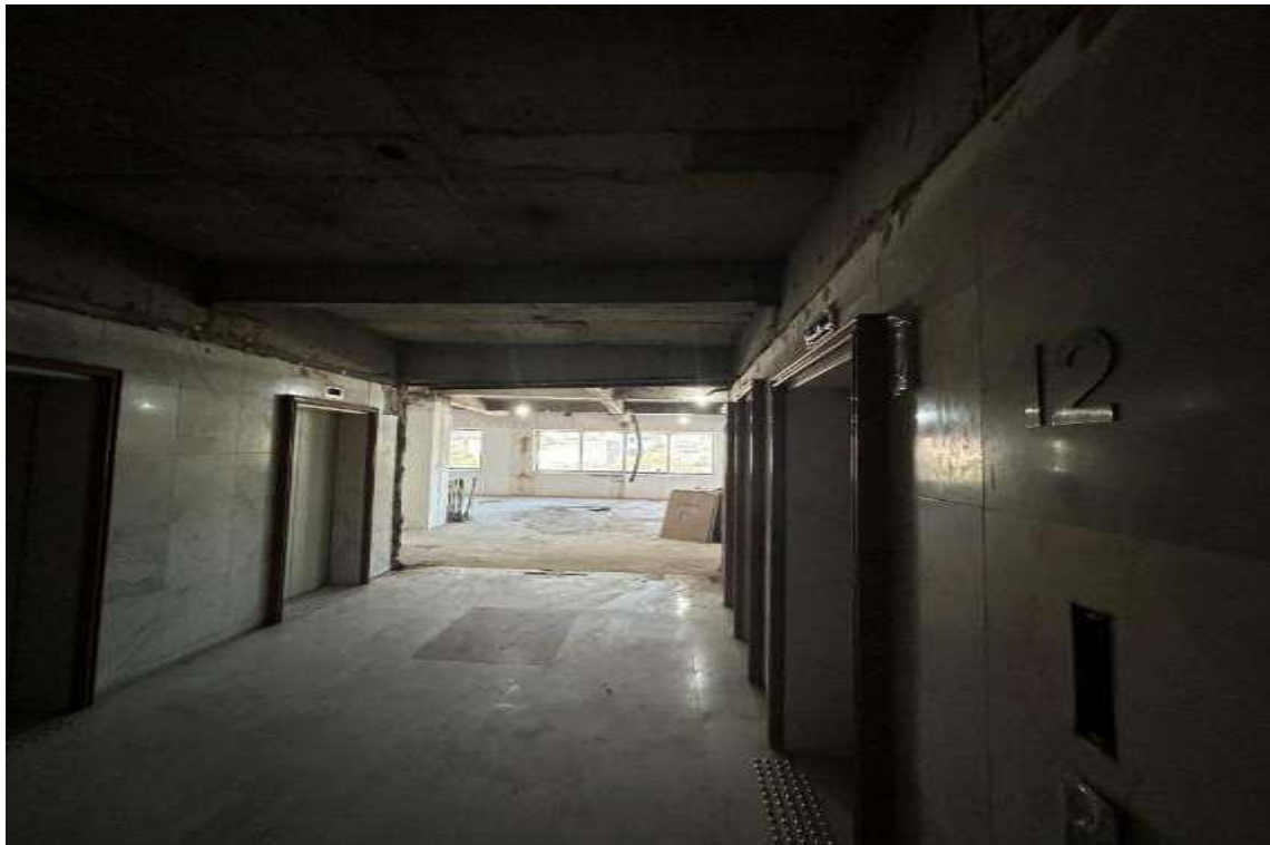
12º Andar – Hall Elevadores Em Obras
