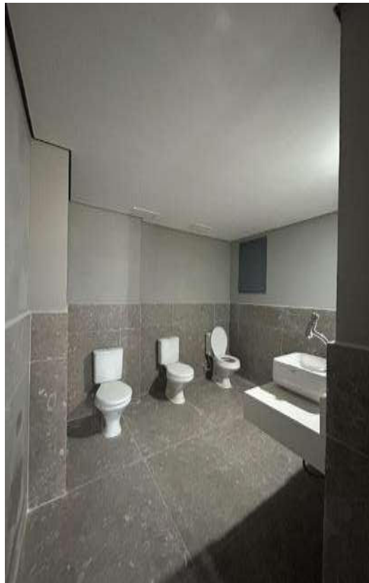
Conjunto 81 – Sanitário Em Obras
