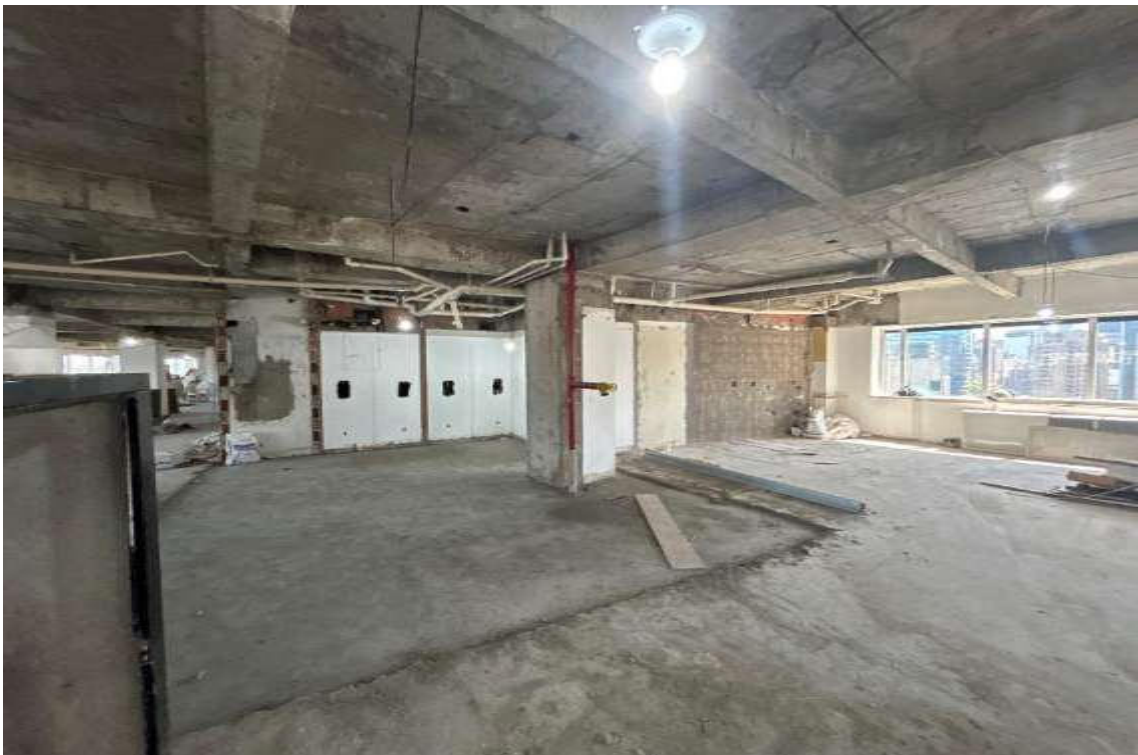
13º Andar – Em Obras
