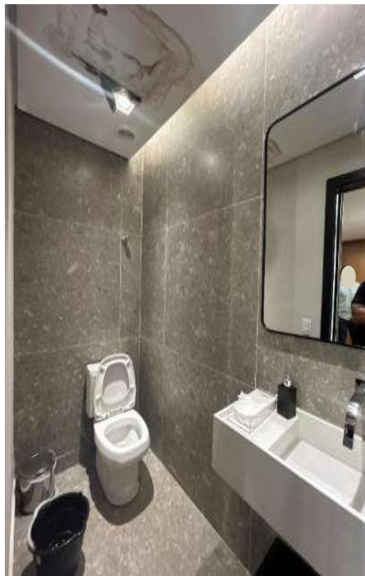
Conjunto 12B – Sanitário
