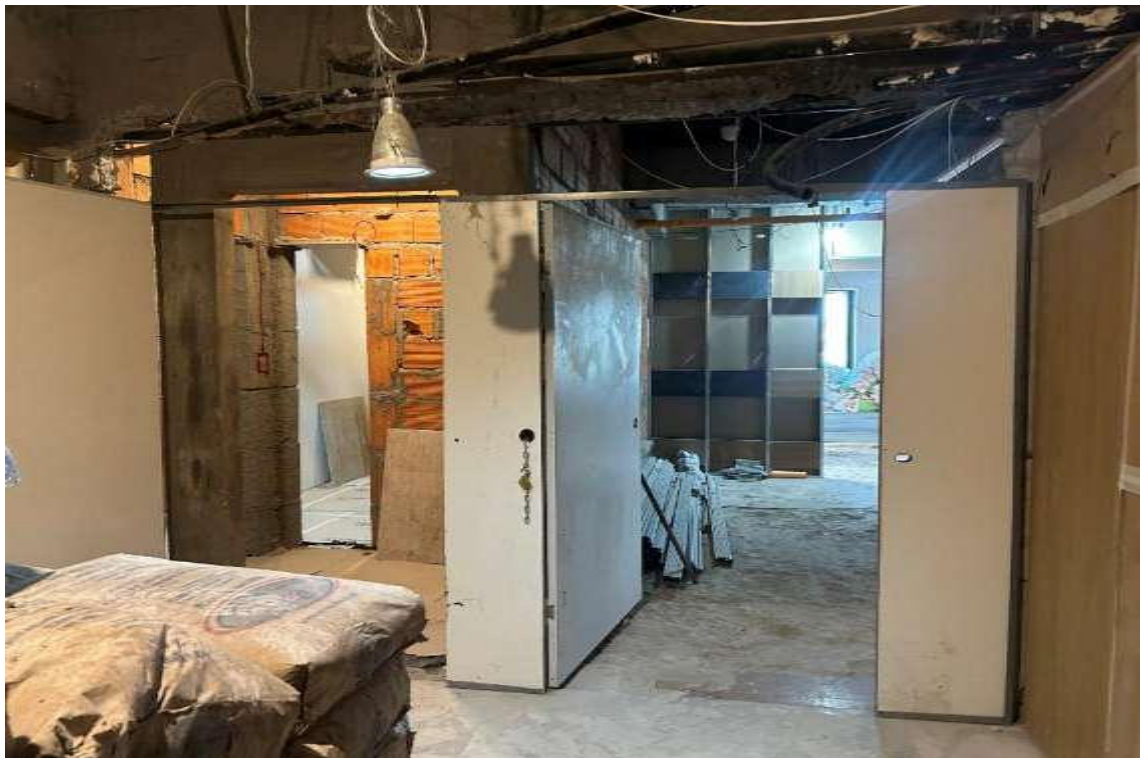
Conjunto 151 – Em Obra
