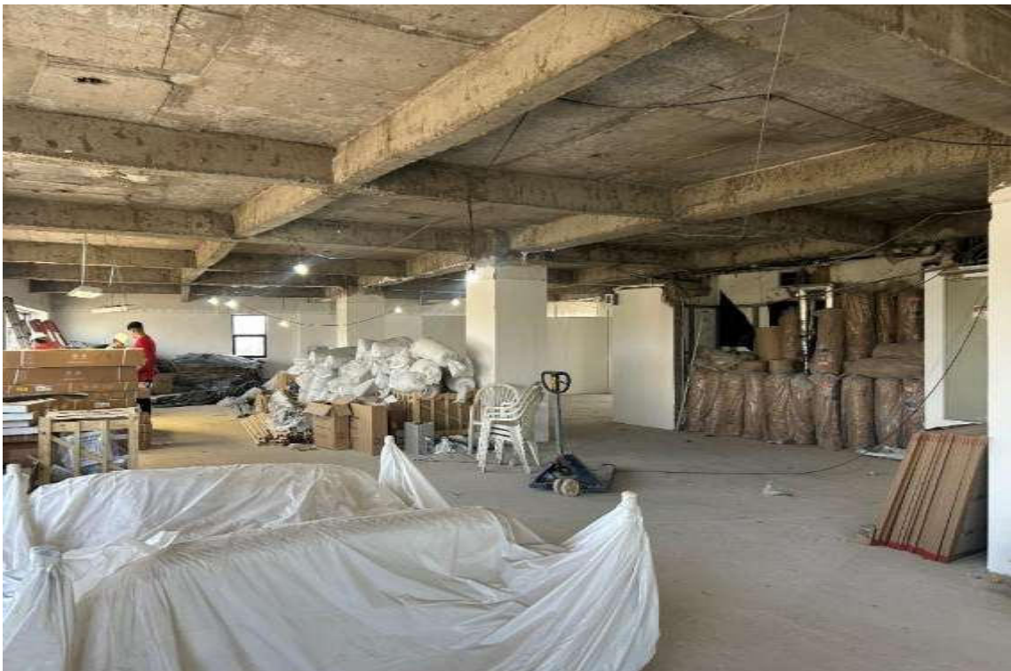
13º Andar – Em Obras
