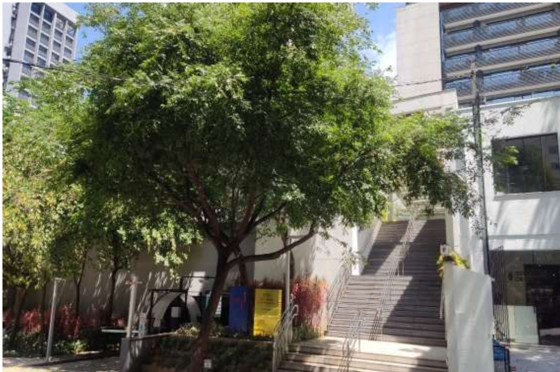
Térreo – Entrada Secundária para o Edifício pela Rua Arthur de Azevedo
