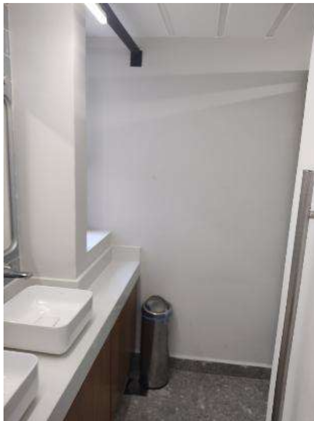
CONJUNTO Nº 112 – SANITÁRIO
