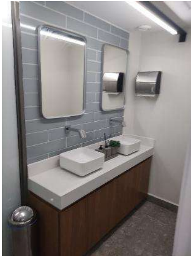
CONJUNTO Nº 112 – SANITÁRIO
