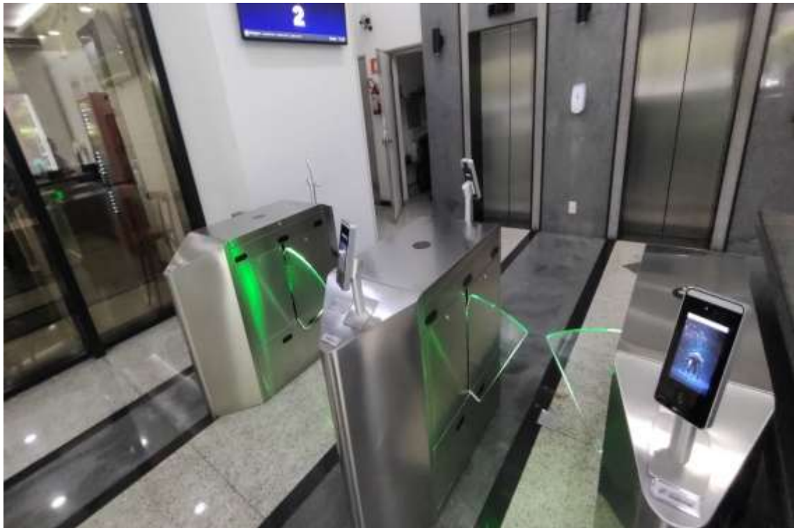
Térreo – Acesso aos Elevadores
