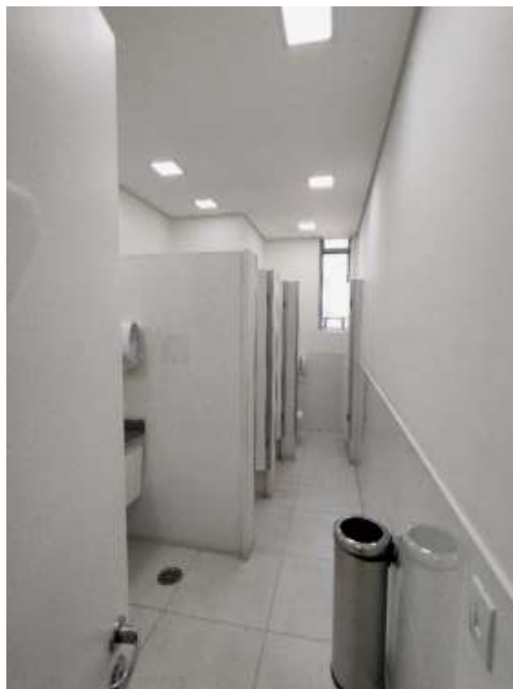
Conjunto nº 142 - sanitário
