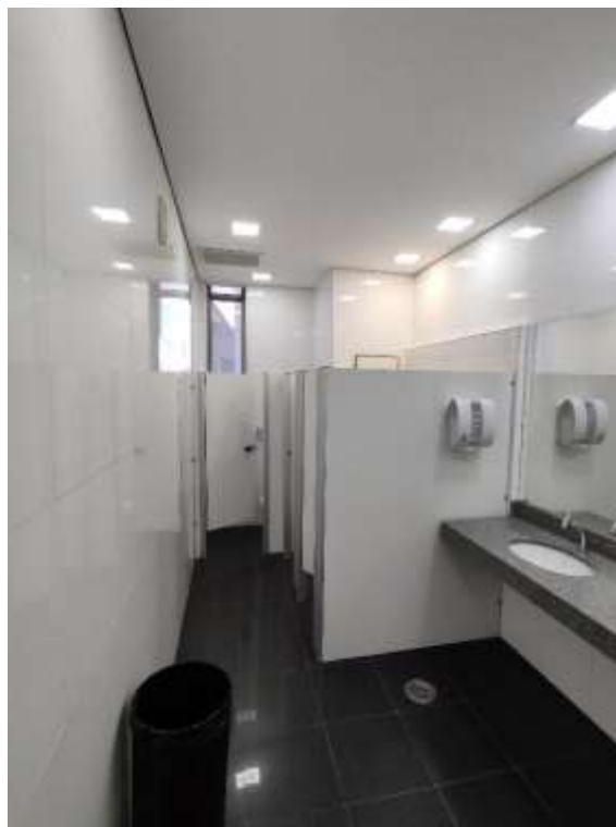
Conjunto nº 142 - sanitário
