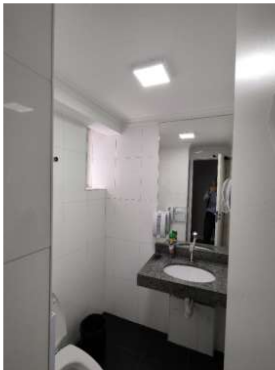
Conjunto nº 142 - sanitário
