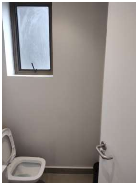
Conjunto 91 e 92 – sanitário
