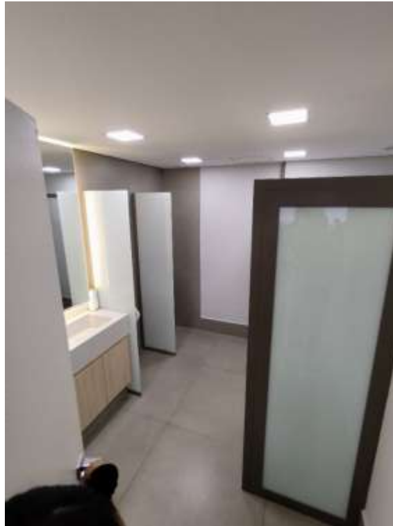
Conjuntos nº 133 e 134 – sanitário– pavimento superior
