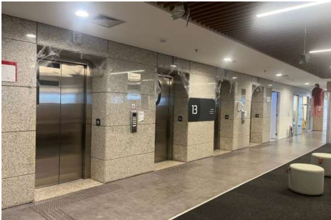
Conjunto 141 e 142 – Hall de Elevadores
