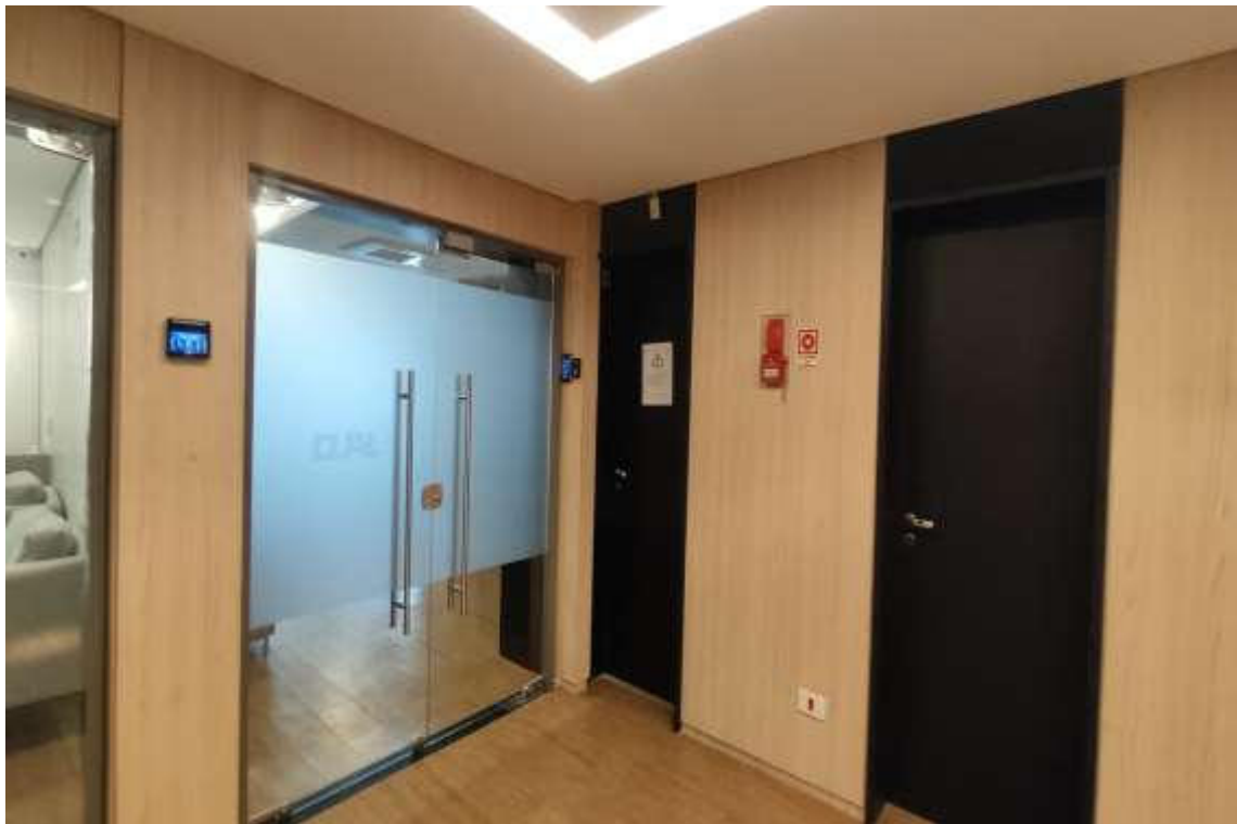
Conjunto 51 – Acesso a Unidade
