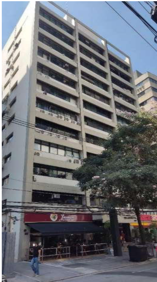
Fachada do Edifício
