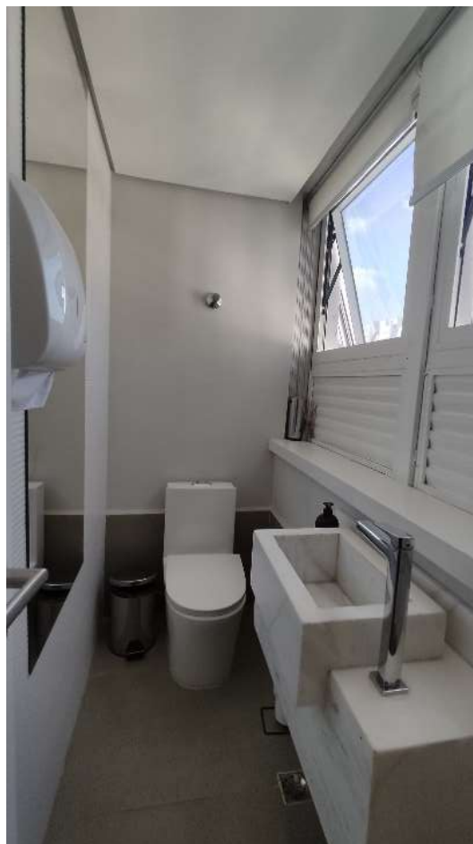
Conjunto 92 E 94 – Sanitário
