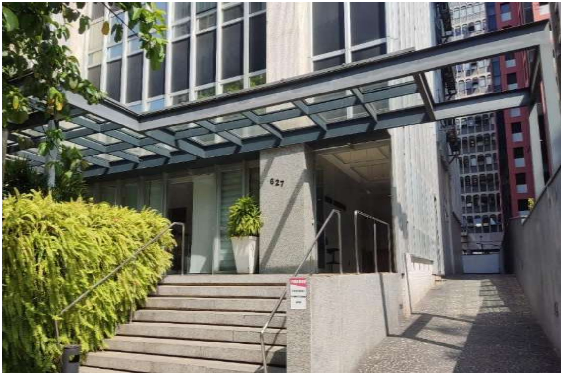
Entrada Do Edifício
