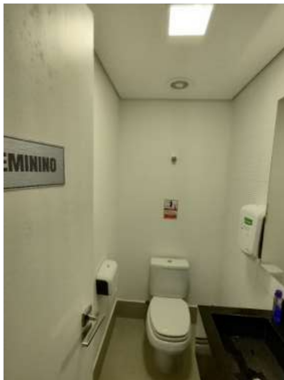
Conjunto nº 2 a e 2 b -sanitário
