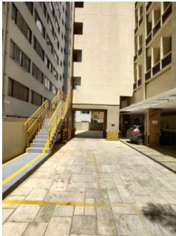
Acesso ao estacionamento – térreo – área comum
