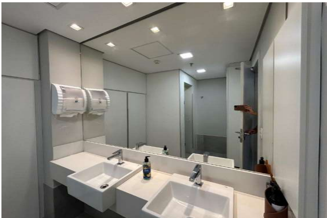
Conjunto E06-B – Sanitário
