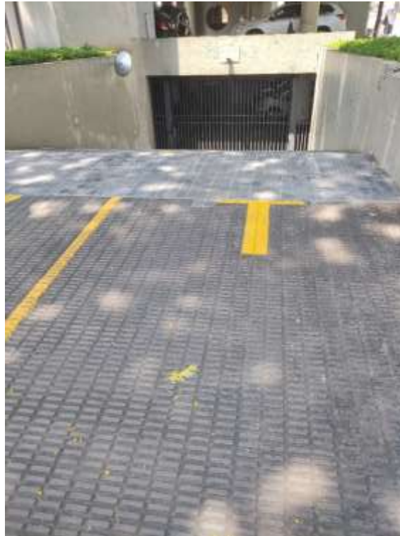
Rampa de acesso ao subsolo
