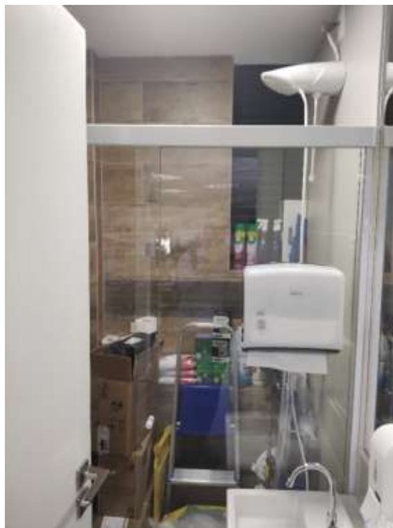
Conjunto 21 e 22 - sanitário
