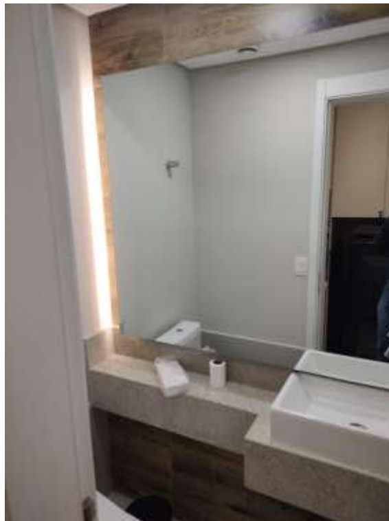
Conjunto unificado nº 1207 ao 1213 – sanitário
