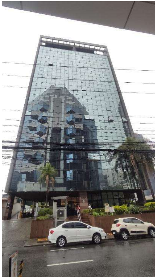
Térreo – Fachada Do Edifício
