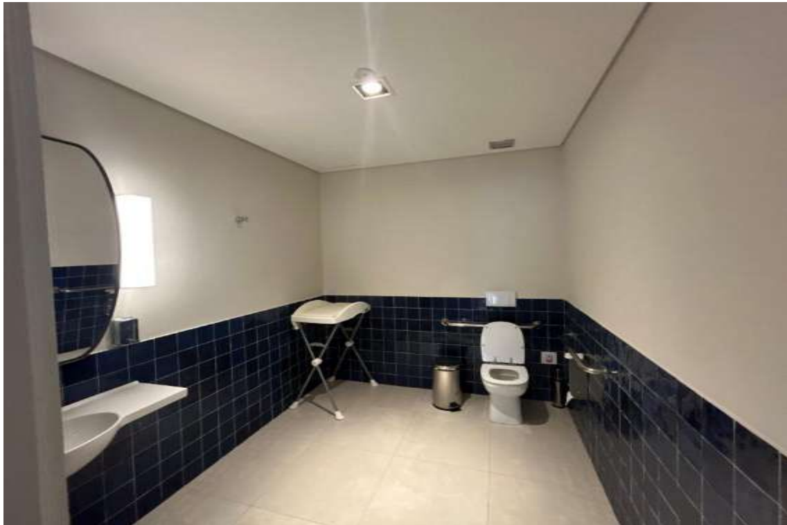
Conjunto 401 – Sanitário Acessível
