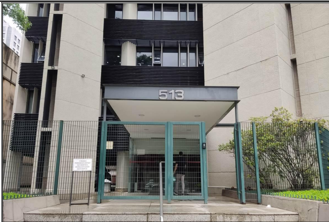
ENTRADA DO EDIFÍCIO
