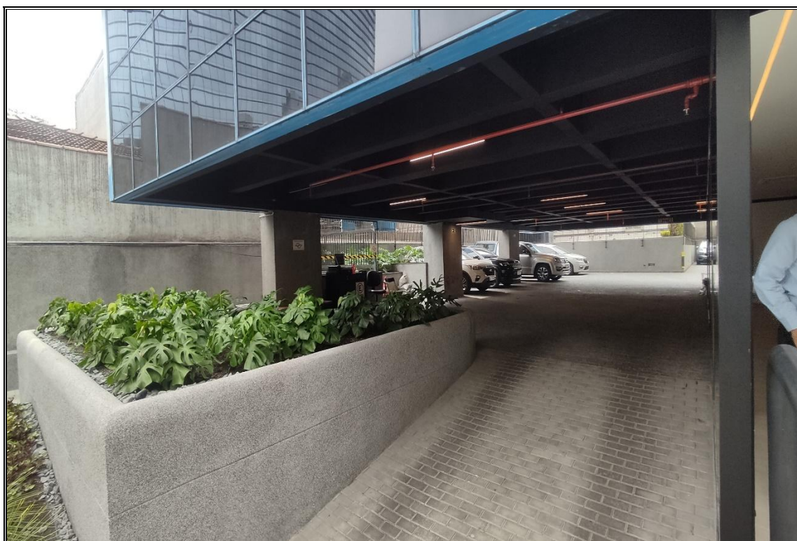
RAMPA DE ACESSO AO ESTACIONAMENTO
