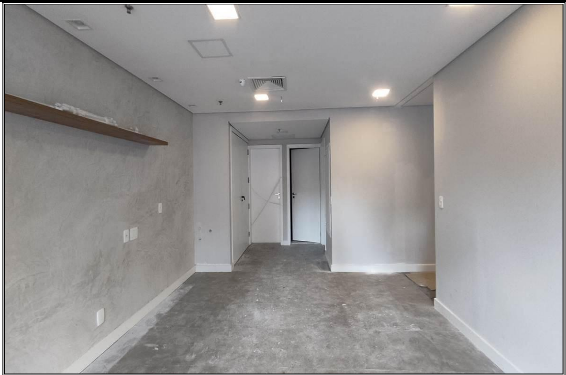
CONJUNTO 111 – EM REFORMA
