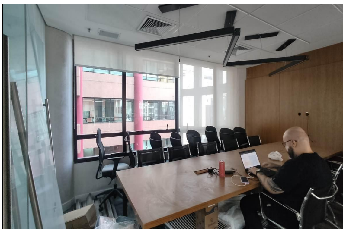
CONJUNTO 111 – EM REFORMA
