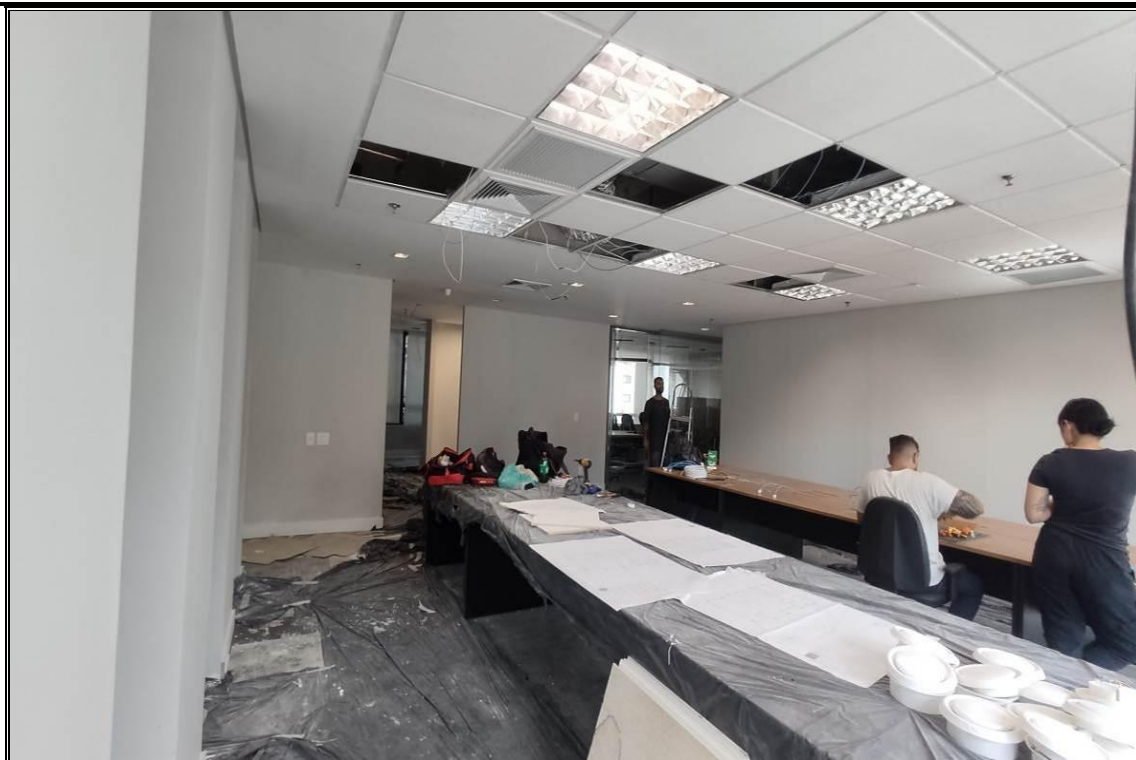
CONJUNTO 111 – EM REFORMA
