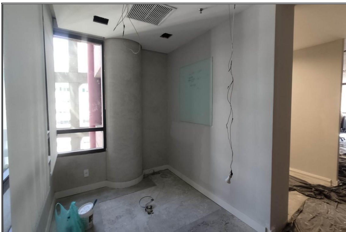
CONJUNTO 111 – EM REFORMA
