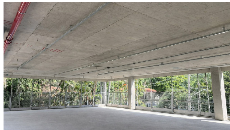
FOTO DA OBRA
