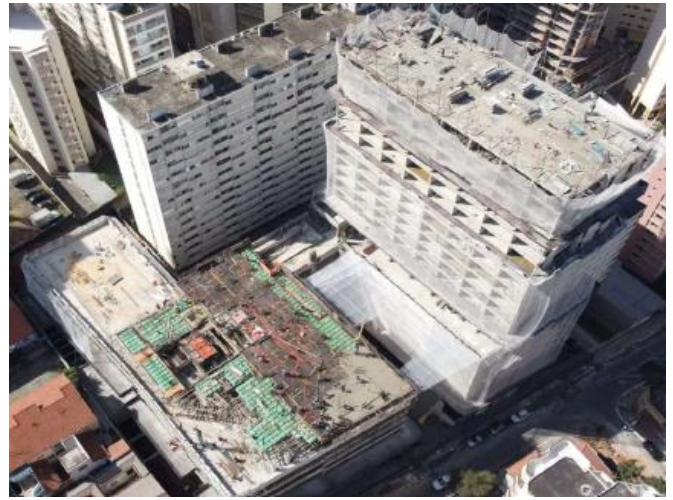
Foto Estrutura da Obra
