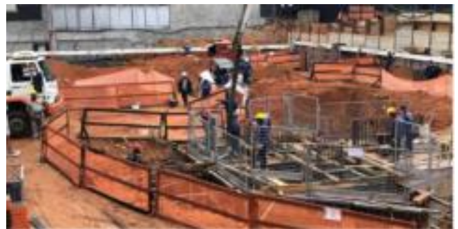
Foto da Escavação da Obra
