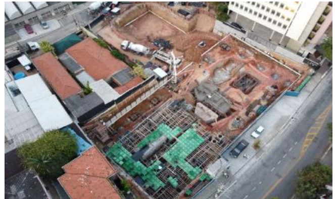
Foto da Escavação da Obra
