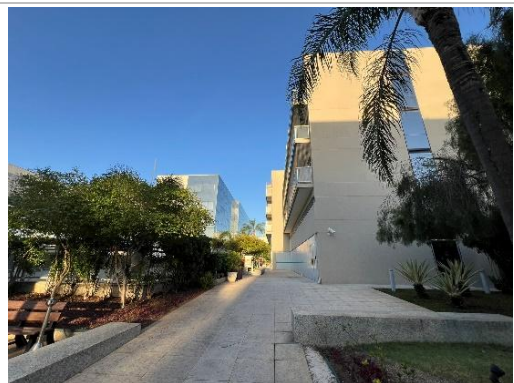
Vista circulação interna do empreendimento
