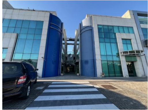
Acesso recepção do condomínio
