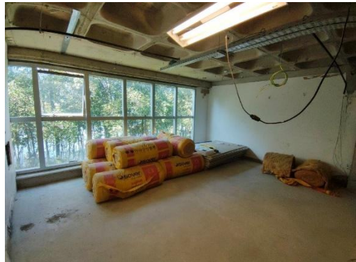
Loja 105 (em obras)
