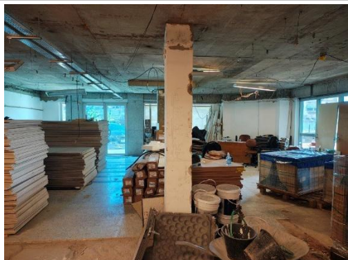
Loja 105 (em obras)
