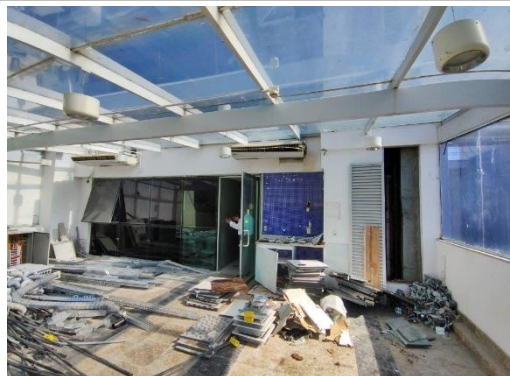
Loja 105 (em obras)
