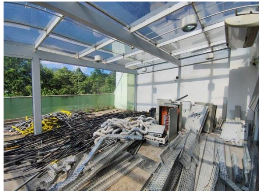
Loja 105 (em obras)
