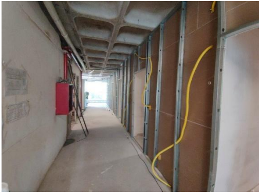
Loja 105 (em obras)
