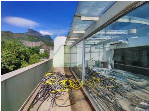
Loja 105 (em obras)
