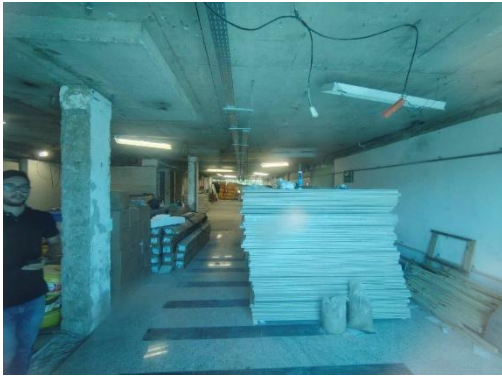
Loja 105 (em obras)
