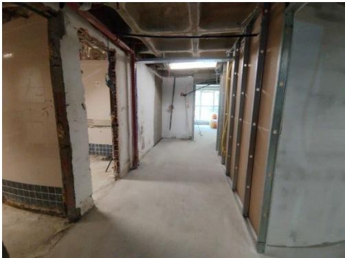
Loja 105 (em obras)
