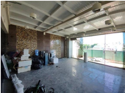
Loja 105 (em obras)
