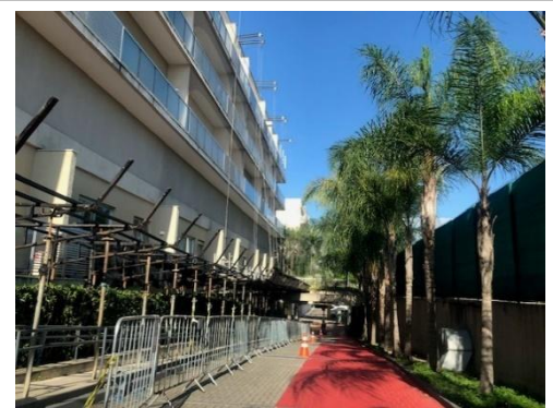
Acesso de veículos para o subsolo
