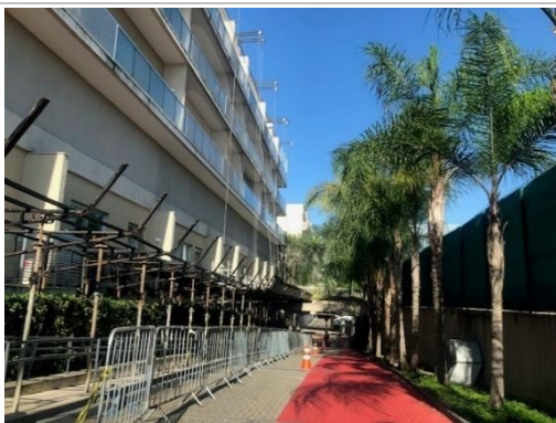
Acesso de veículos
