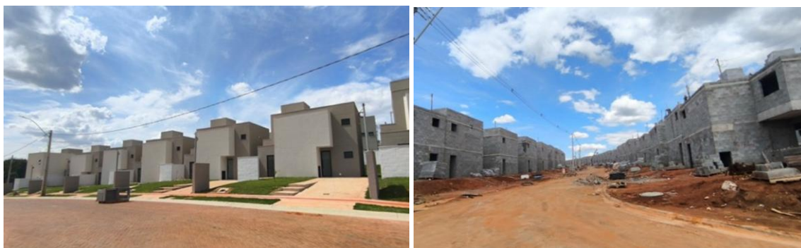
Foto de evolução de obras das fases I e II do empreendimento alvo do CRI FGR; Fonte: Hauze Engenharia.
