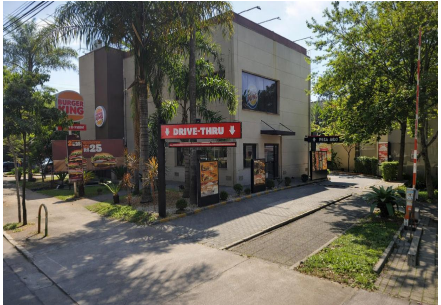
Vista da loja Burger King, âncora localizada na extremidade do empreendimento Atlântica Mall
