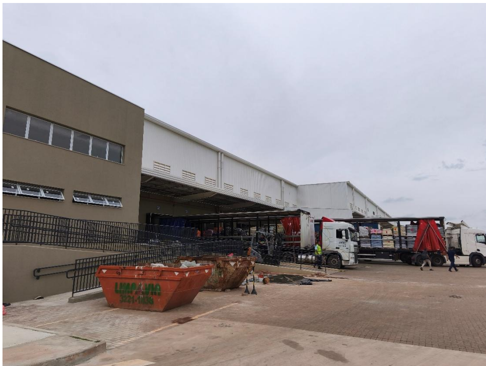
EXTERIOR DO GALPÃO
