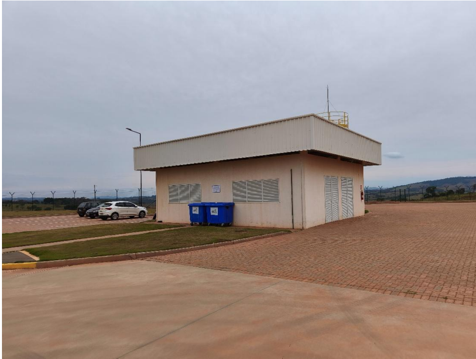
EDIFICAÇÕES DE APOIO
