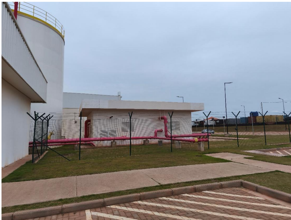
EDIFICAÇÕES DE APOIO
