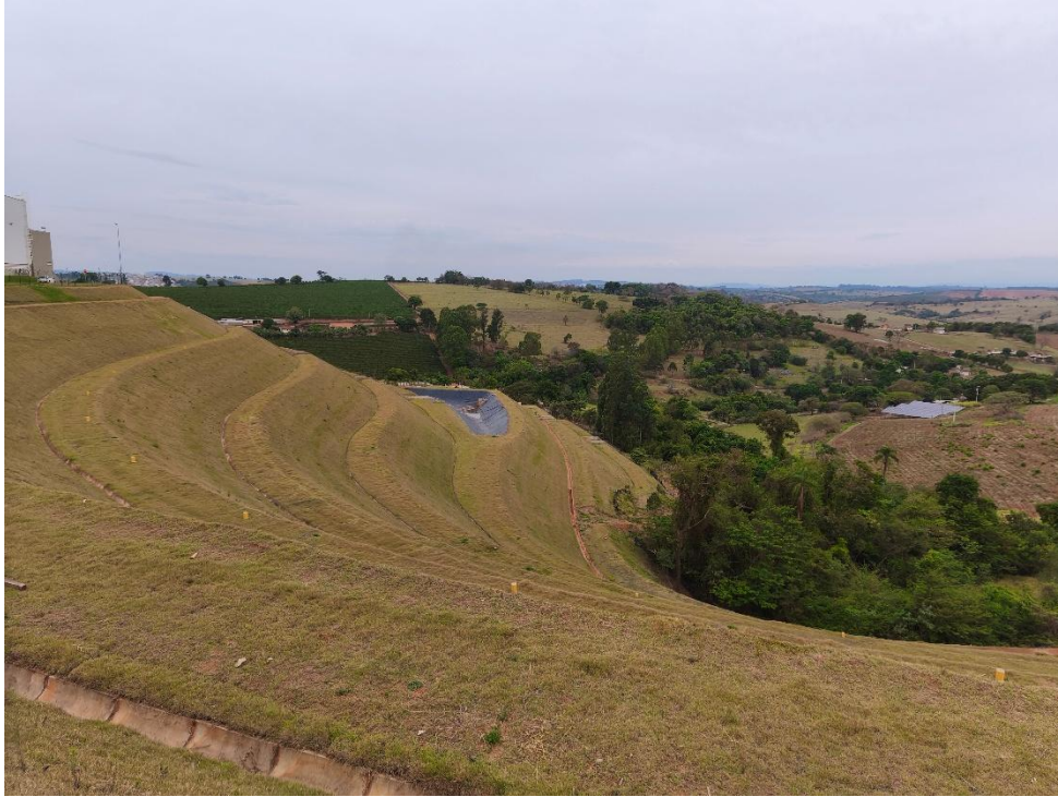
ENTORNO DO EMPREENDIMENTO
