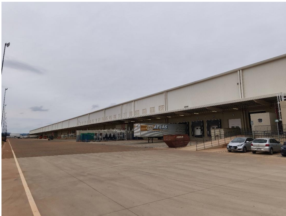
EXTERIOR DO GALPÃO
