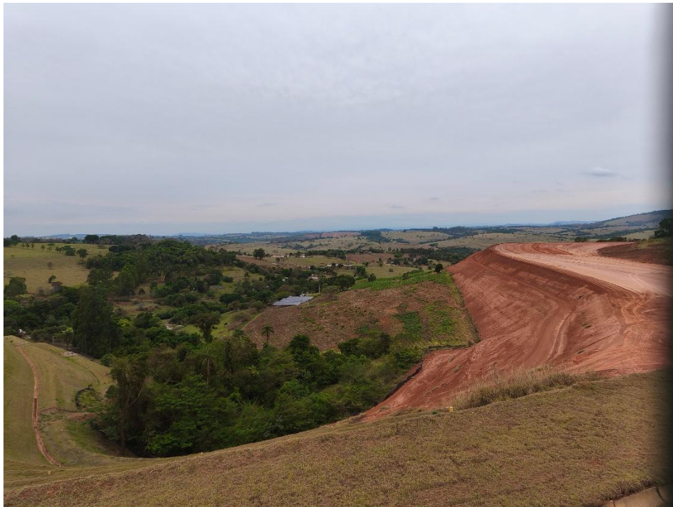
ENTORNO DO EMPREENDIMENTO
