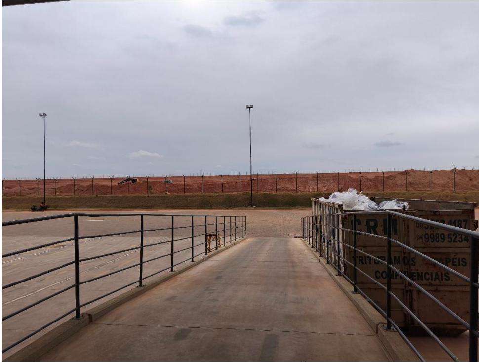
EXTERIOR DO GALPÃO
