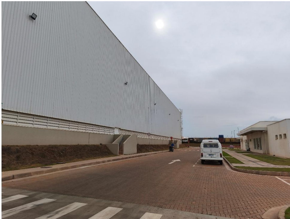
EXTERIOR DO GALPÃO
