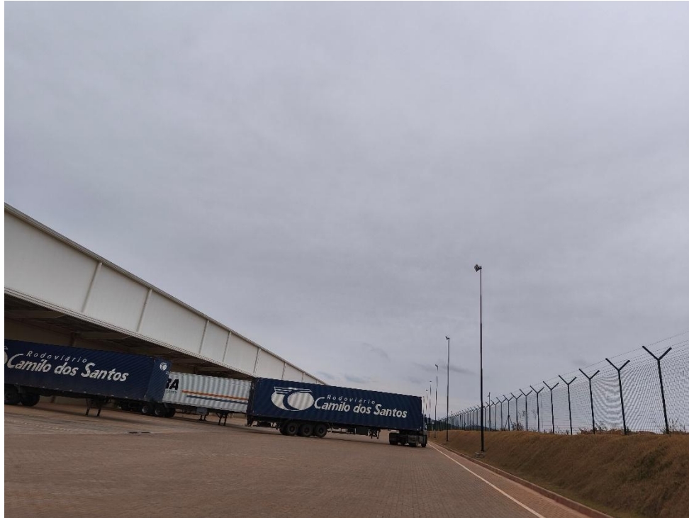
EXTERIOR DO GALPÃO
