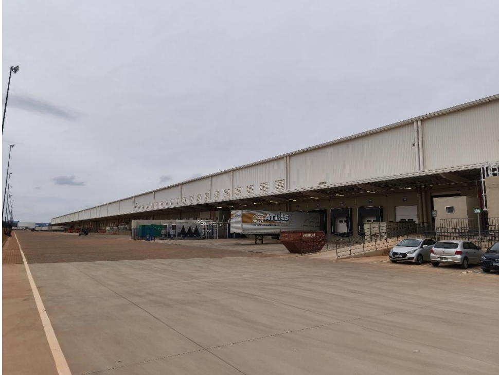
EXTERIOR DO GALPÃO
