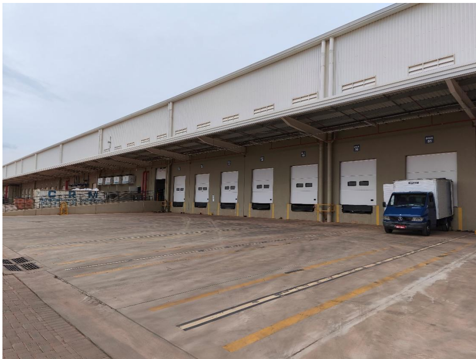
EXTERIOR DO GALPÃO (DOCAS)
