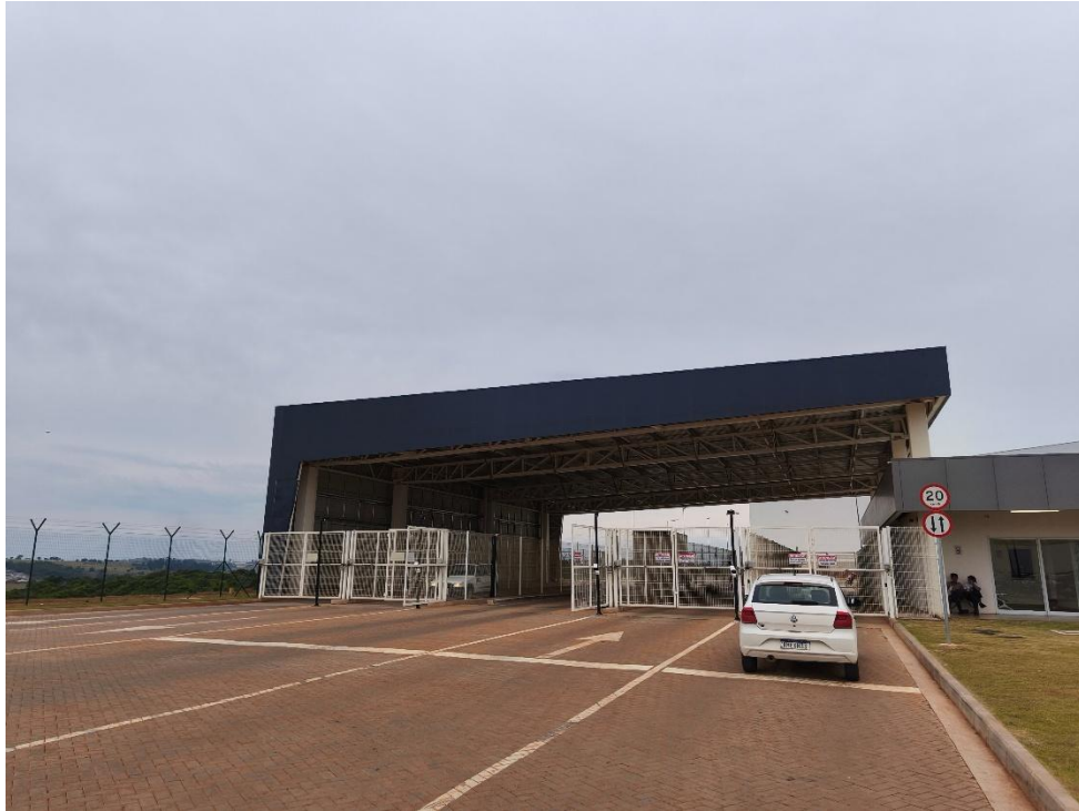
ACESSO PRINCIPAL – CITLOG 3
