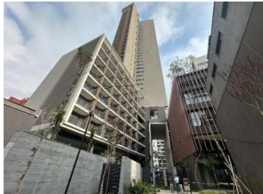
Vista interna das Torres
