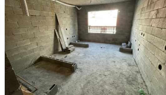
Marcação de alvenaria vedação
