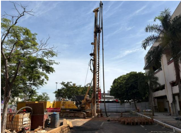
Em andamento Fundação em hélice contínua. Fonte: Alqia e HSI
