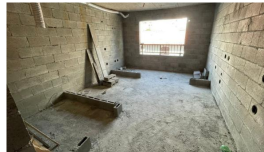
Marcação de alvenaria vedação
