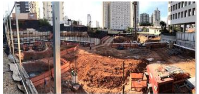
Foto da Escavação da Obra
