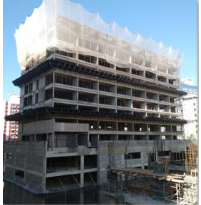
Foto Estrutura da Obra
