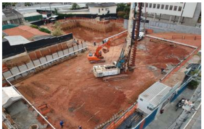
Foto da Escavação da Obra
