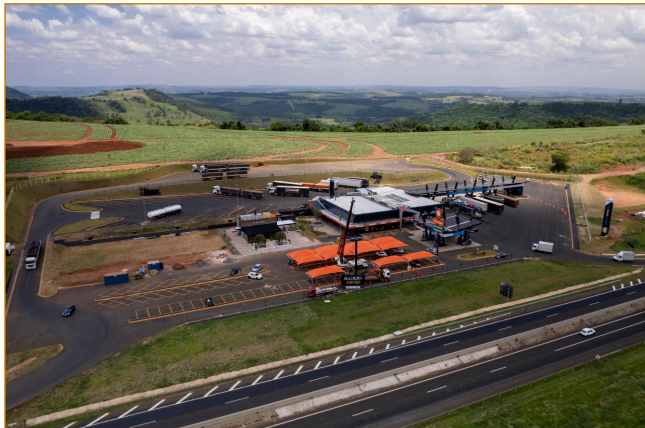
Posto de Combustível da Rede Monte Carlo, localizado na Rodovia Washington Luís, km 198, Corumbataí – SP.
