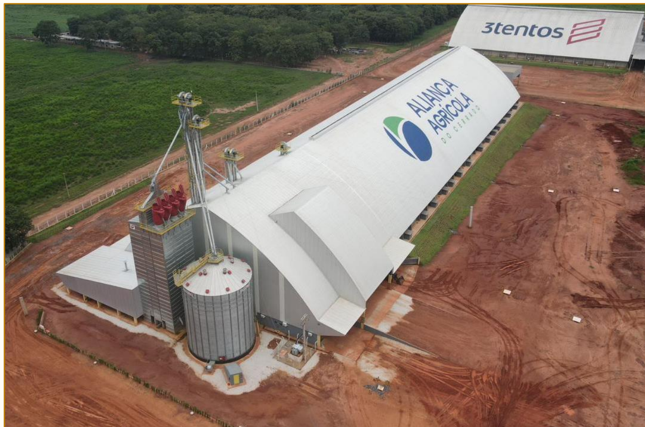
Armazém de grãos da Sodrugestvo Agronegócio S.A., localizado na MT-338, na zona urbana de Porto dos Gaúchos – MT.
