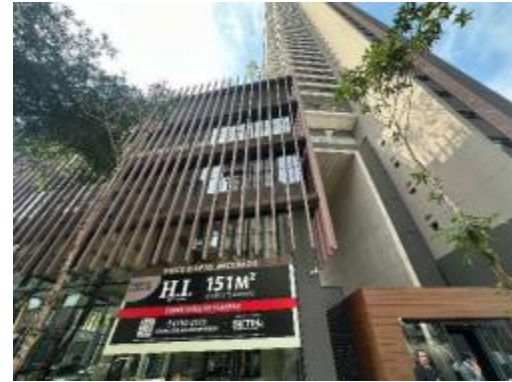
Vista externa da Torre
