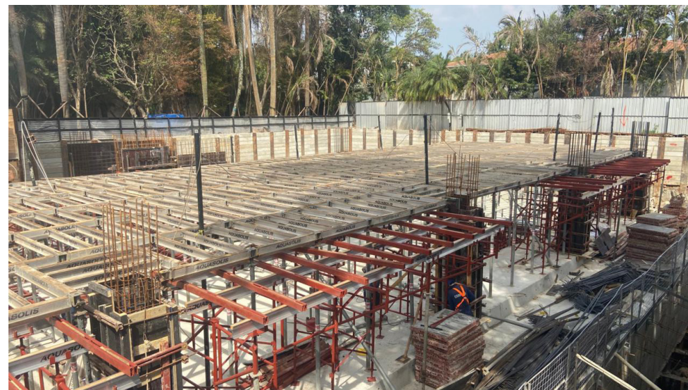
FOTO DA OBRA
