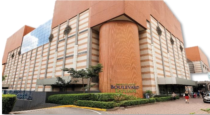
Shopping Metrô Boulevard Tatuapé
