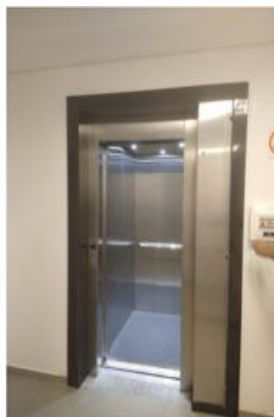
Cabine do elevador
