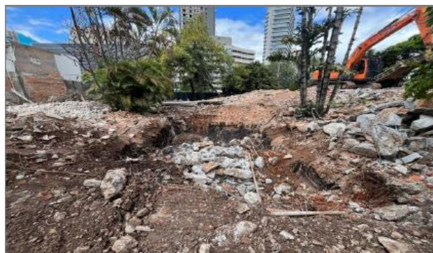
Demolição de fundações
