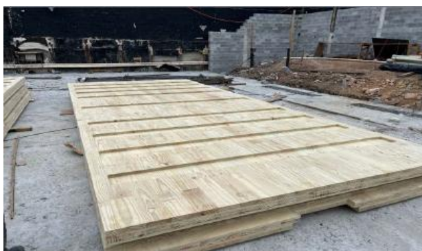
Face superior da laje de madeira
