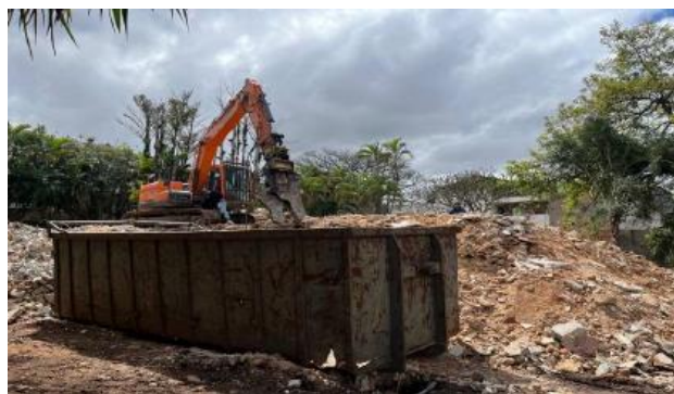
Demolição de estruturas
