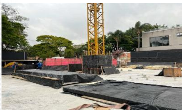
Visão geral laje concretada
