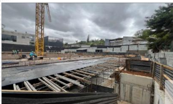
Visão geral formas e escoramentos
