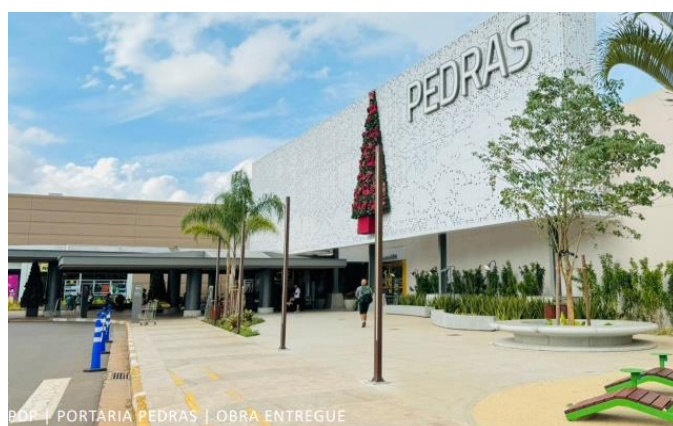
PDP | PORTARIA PEDRAS | OBRA ENTREGUE
