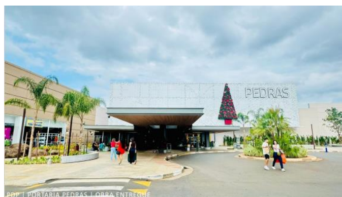
PDP | PORTARIA PEDRAS | OBRA ENTREGUE
