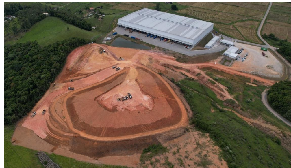
Terraplanagem Nave 2 – Foto Panorâmica
