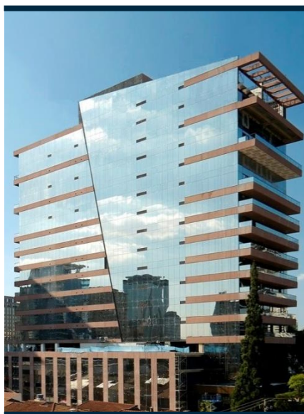
Fachada do Edifício The One
