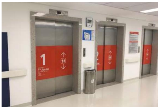
Hall dos Elevadores
