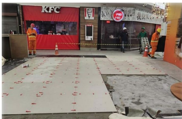
Instalação de porcelanato.
