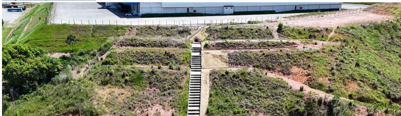
Imagem 6: Reparos no Talude
