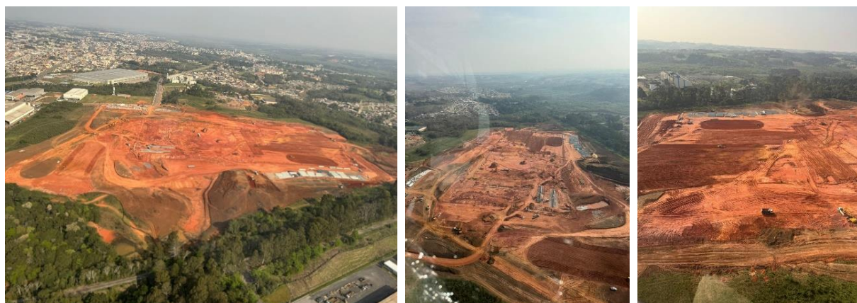
Imagens aéreas BTS Meli tiradas em Setembro/2024 (obra em fase de terraplanagem do terreno) Fonte: Grupo HSI
