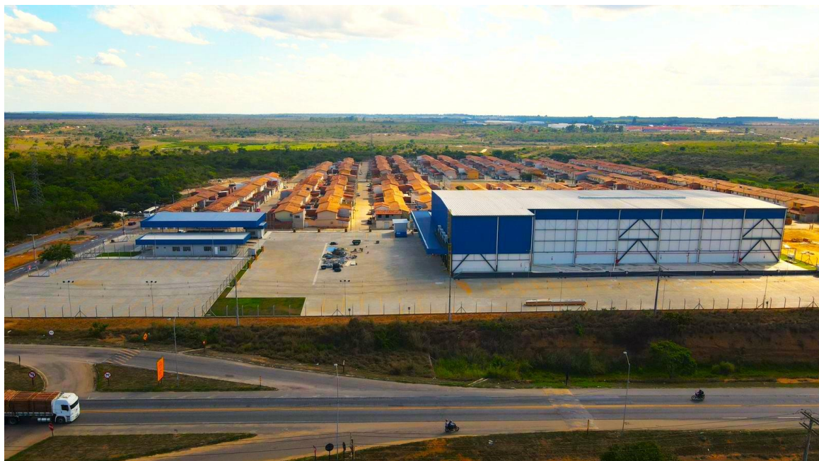
Execução de obra Seara VDC/BA – Foto Panorâmica
