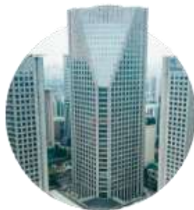
Ativo CENU Torre Oeste
